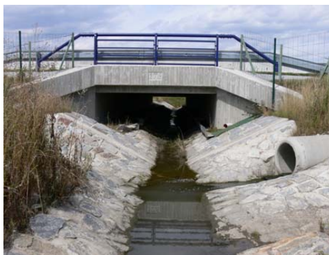
Obr. 3 Upravené koryto Pamětníku severozápadně od obce Klamoš
