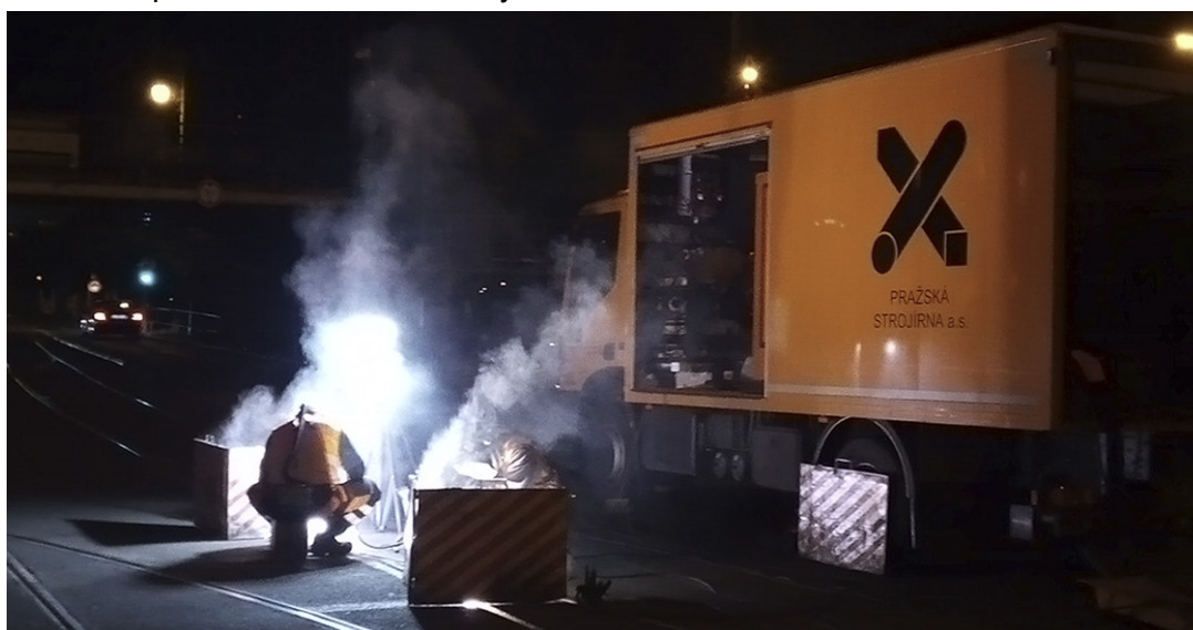
Obr. 4: Reprofilace žlábků srdcovky navařováním
