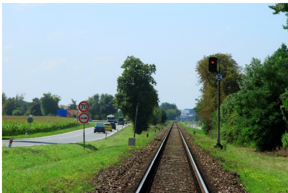
Železnice a silnice na západě lokality
