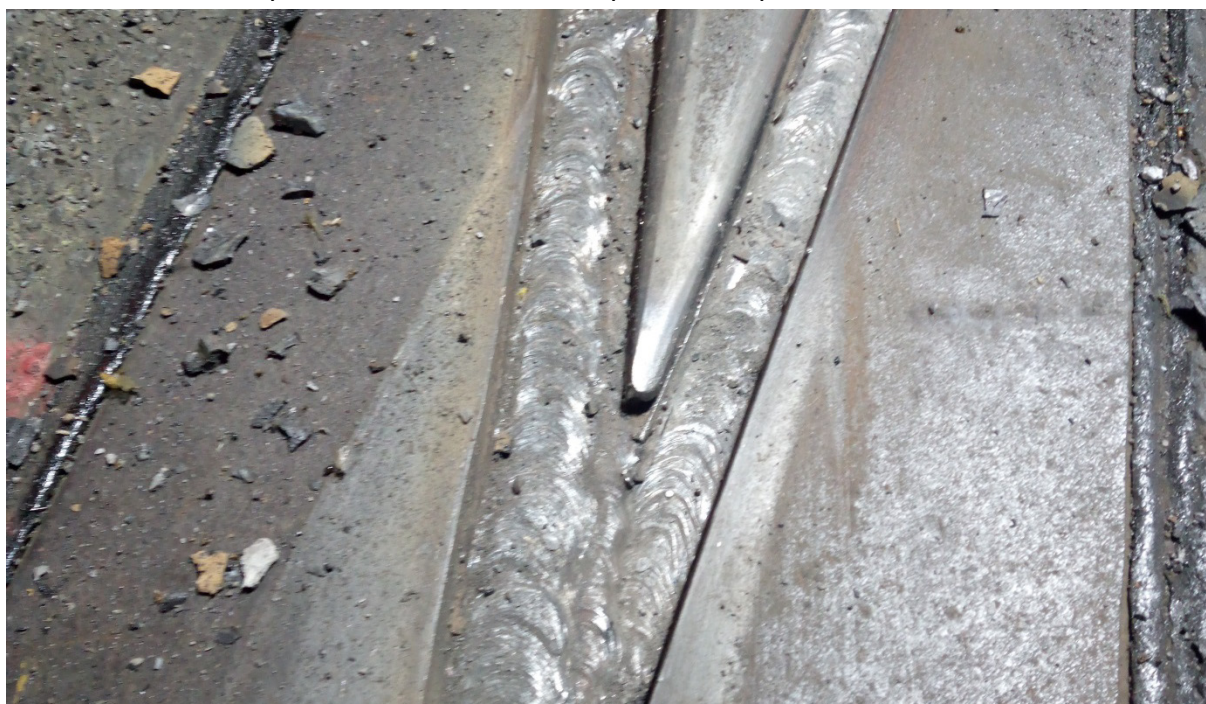
Obr. 5: Pohled na reprofilovanou srdcovku bezprostředně po navaření
