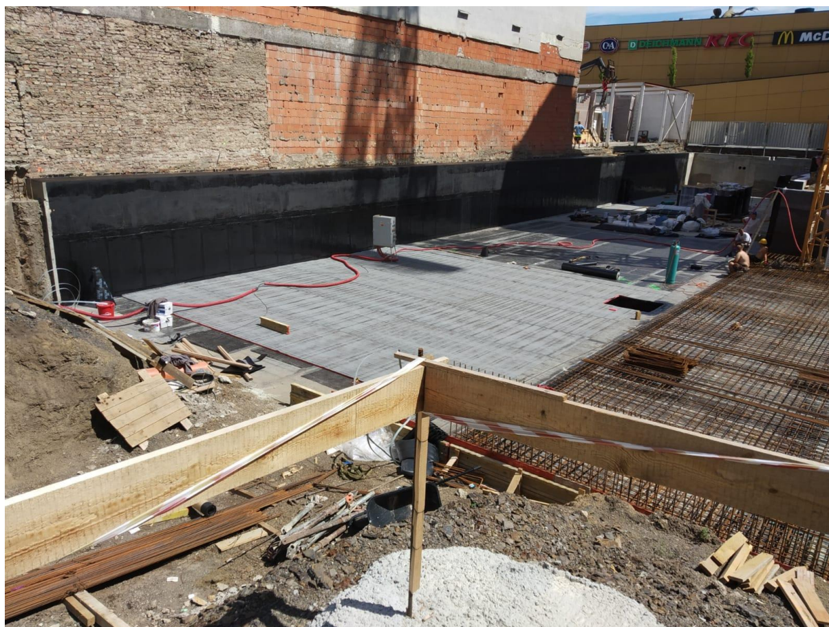
Obr. 3. Příklad pokládky celoplošné vibroizolace
