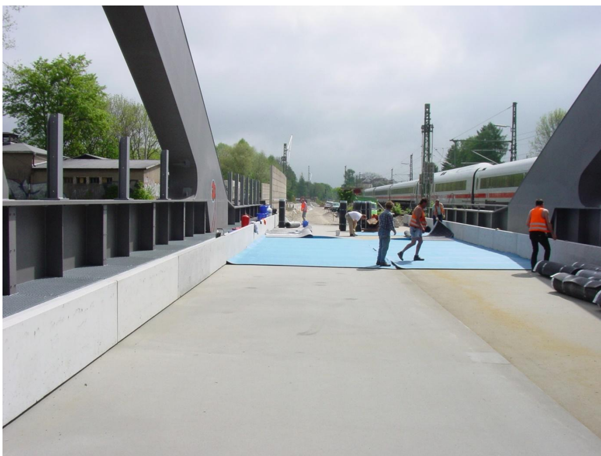
Obr. 2. Příklad pokládky celoplošné vibroizolace
