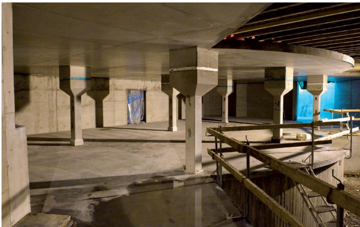
Obr. 5. Příklad pokládky řešení vibroizolace objektu – bodové uložení na rozšířených hlavicích sloupů
